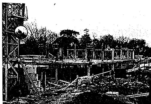
Vue d'ensemble : structure poteaux-plancher
