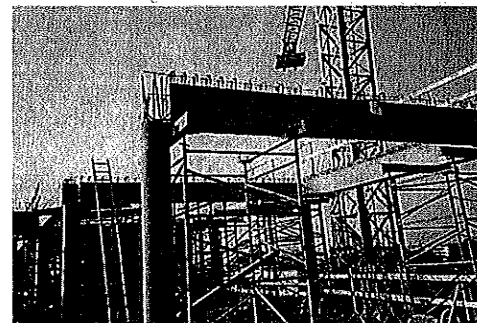
Mise en œuvre de poutres préfabriquées
