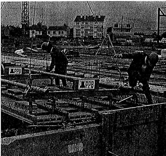
Mise en place d'un plancher « préassemblé ».
