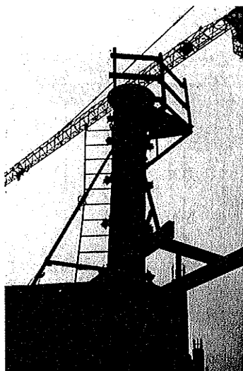
Coffrage d'un poteau de section circulaire
